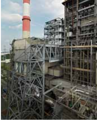
Verbrandingsketel, DeNO x , elektrofilter (vrnl)
