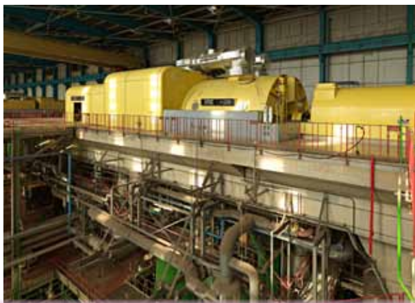
Machinezal met stoomturbine en alternator
