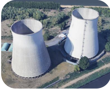
Renovatie koeltorens (« landmark »)
