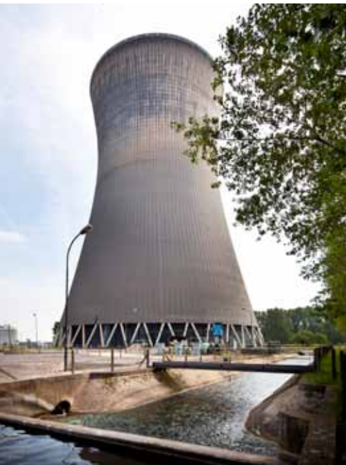
Tour de refroidissement
