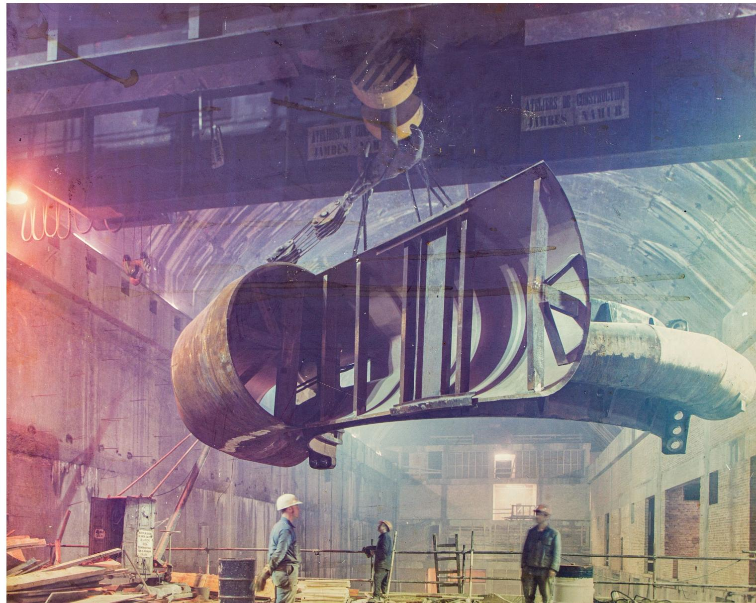
▲ Assemblage d'une bache spirale sur le site de Coe
