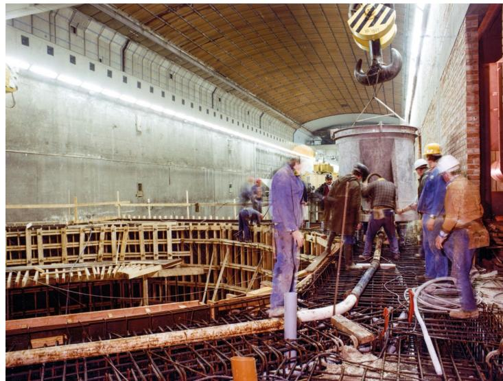
▲ Bétonnage d'un fût d'alternateur • 1977
