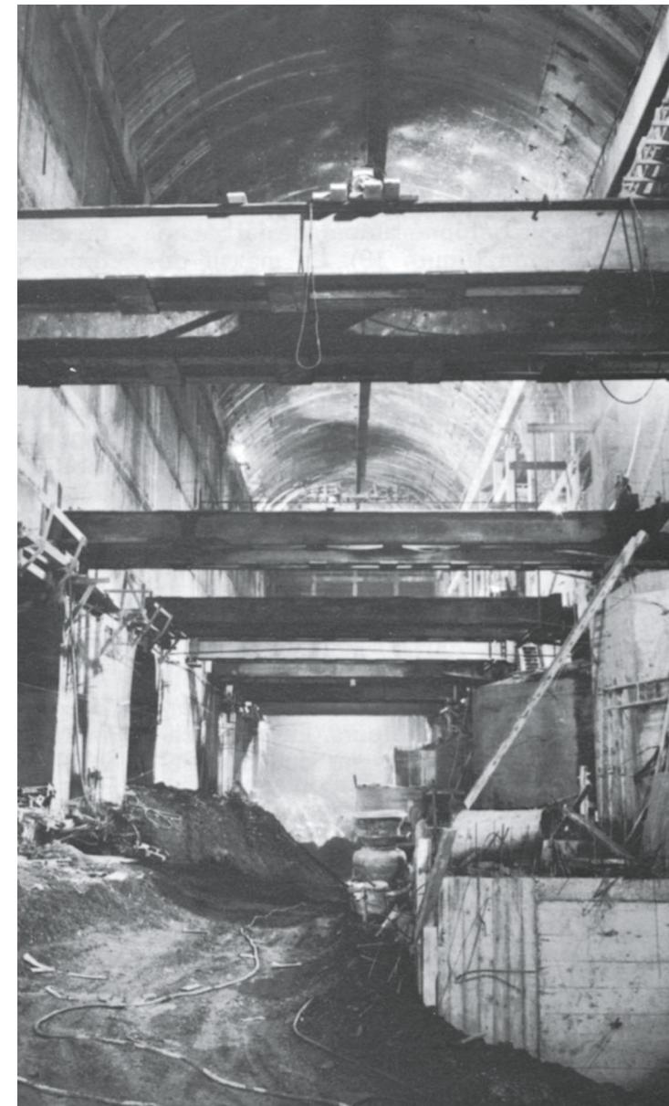
▲ Excavation - butons de soutènement des parois ▲
