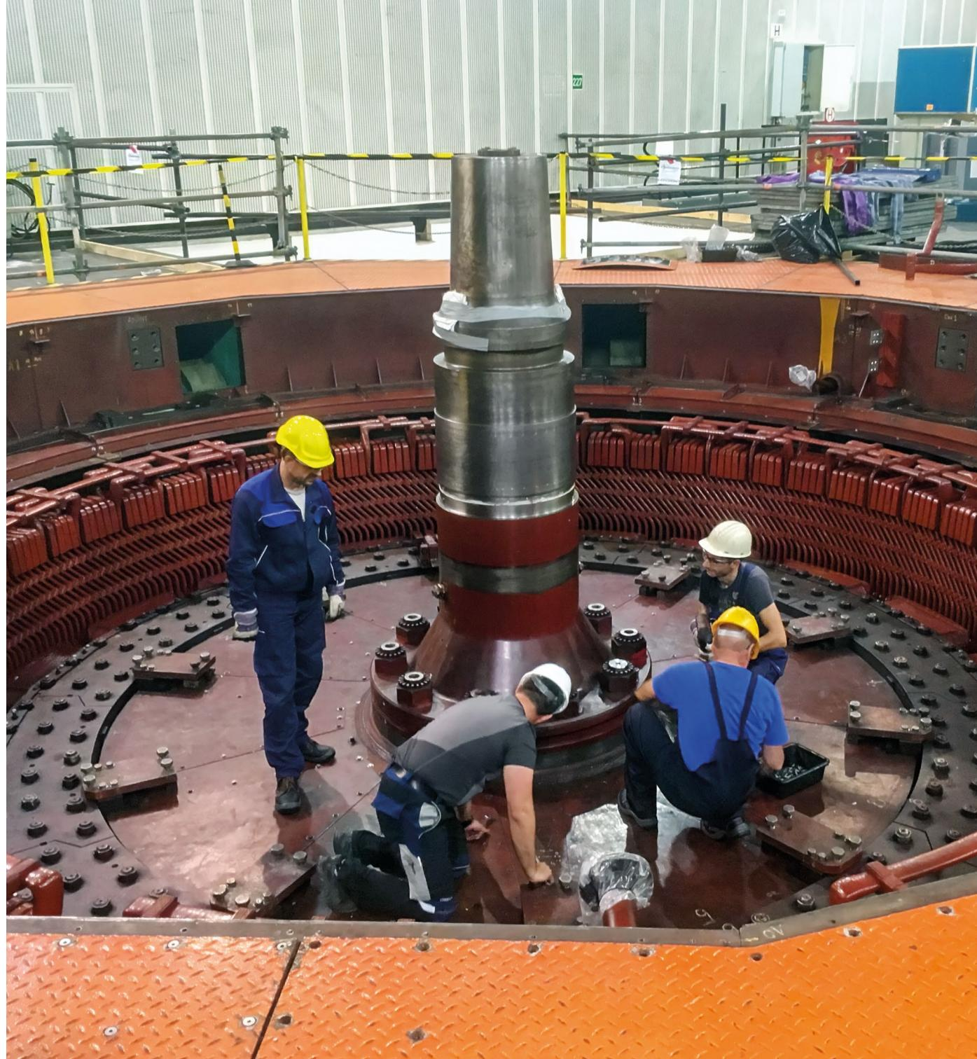
Travaux en cours sur le rotor de l'alternateur d'un groupe de Coo 2
